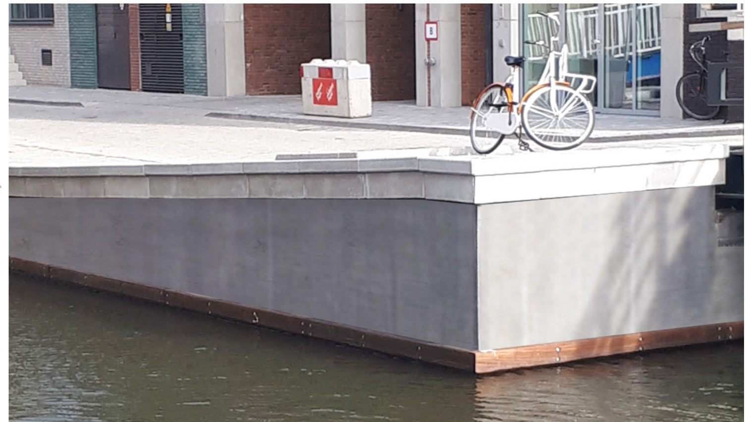
kademuur beton met deksloof
